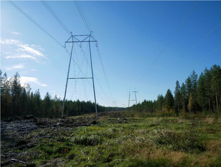
Kuva 76 Nykytila lounaaseen voimajohtolinjalta kohti Möksyn asemaa.
