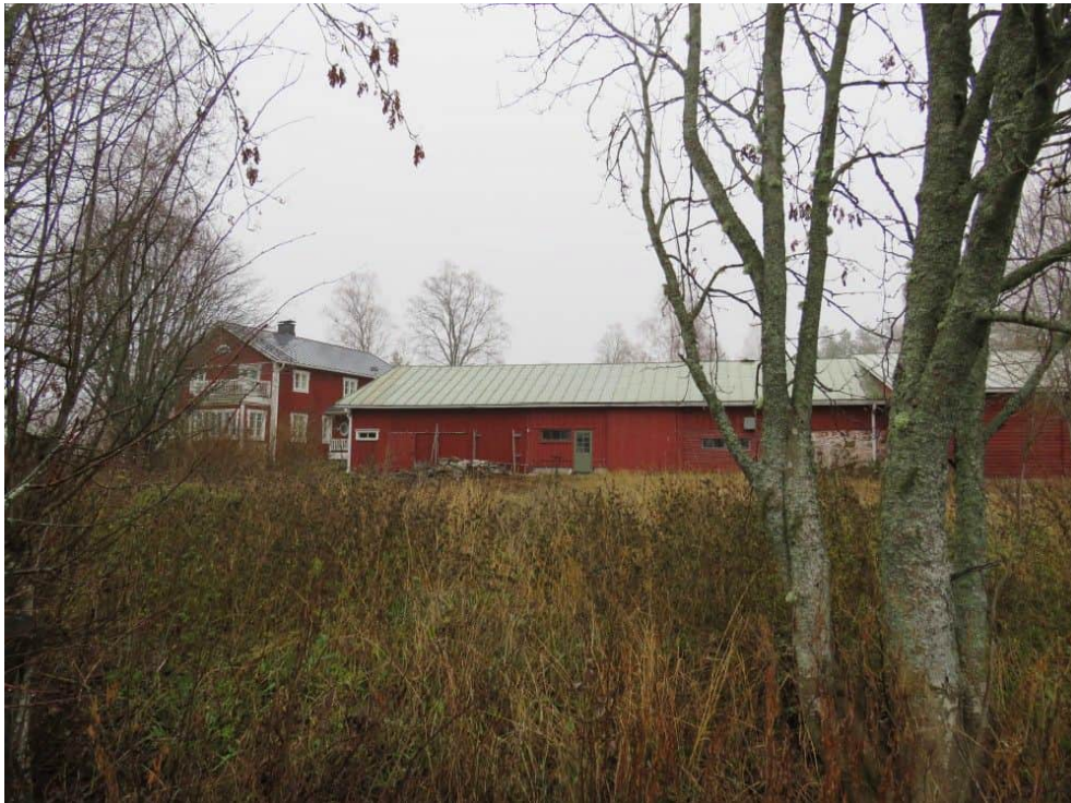
56. Pynttärin/Stor-Pynttärin rakennuskantaa itään.
