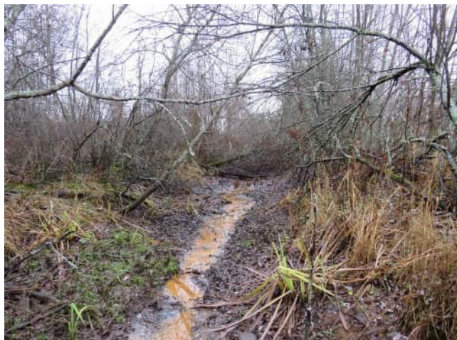
30. Myllyn kanavaa pohjoiseen.
