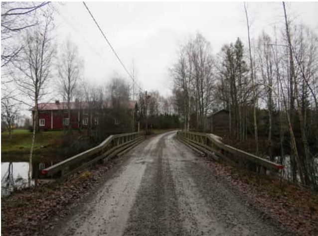
3. Silta Viitasaaren talon kohdalla Koskenniskantiellä, kuva itään.
