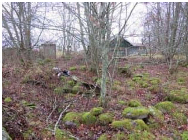
59. Rakennuksen perustuksia itään.
