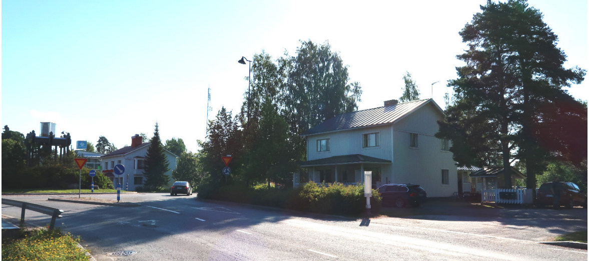
Kuva 7. Hirsikankaantie 2 luoteesta, taustalla Kauppakadun rakennuskantaa, jota ollaan uudistamassa (kuva: Ramboll 2020).
