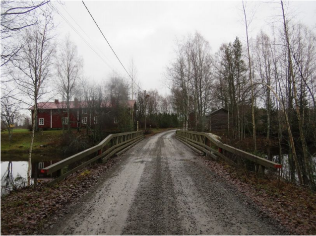
3. Silta Viitasaaren talon kohdalla Koskenniskantiellä, kuva itään.
