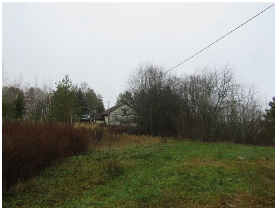
28. Kuva koilliseen Heinikankaan suuntaan.
