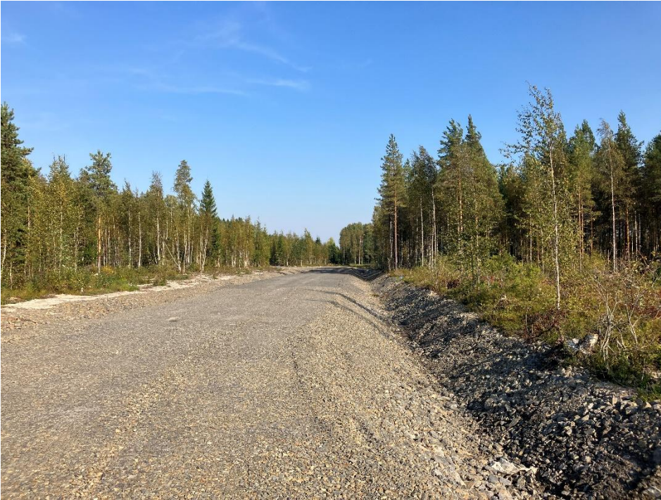
Kuva 4 Varastotien varsi ei ole vielä rakentunut.
