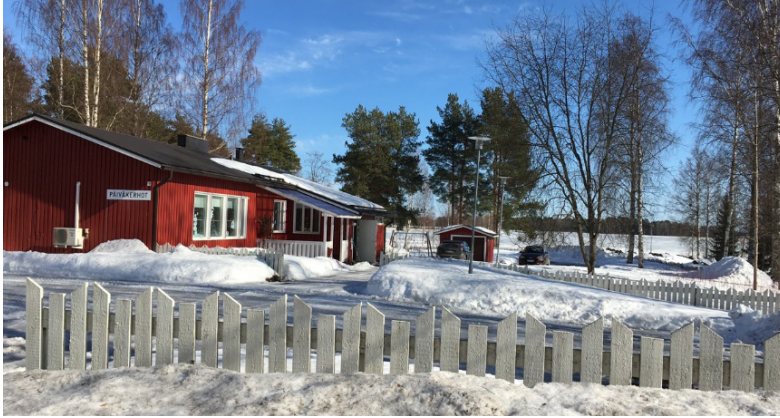
Kuva 12. Satakielen päiväkerhorakennus ja näkymä Hoiskontieltä järven suuntaan (Ramboll 03/2021).
