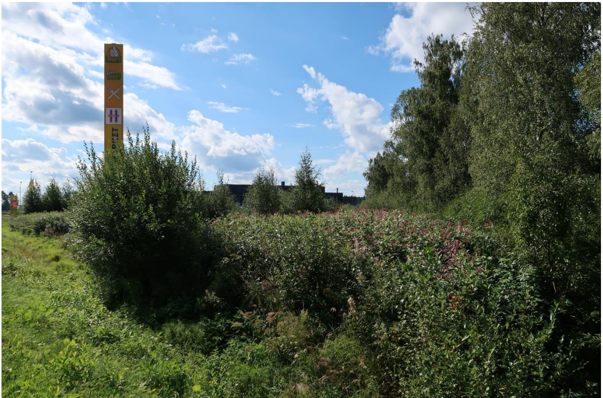
Kuva 8 ABC:n hulevesien tasausallas ©Nelli Nenonen
