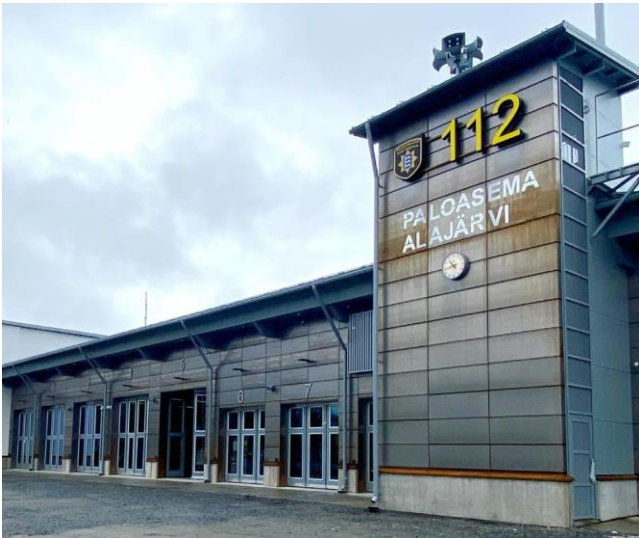
Kuva 1. Vuosien 2019–2021 aikana rakennettu Alajärven uusi paloasema valmistui huhtikuussa 2021.
